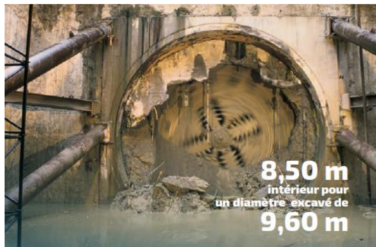
Arrivée du tunnelier Brennus à la station Bagatelle (ligne A) © Patrice Nin
